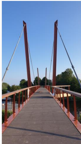
De nieuwe brug juni 2024
