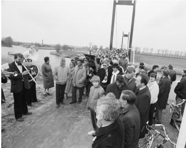
Fietsbrug opening in mei 1985 door A.Brugman (gedeputeerde)
